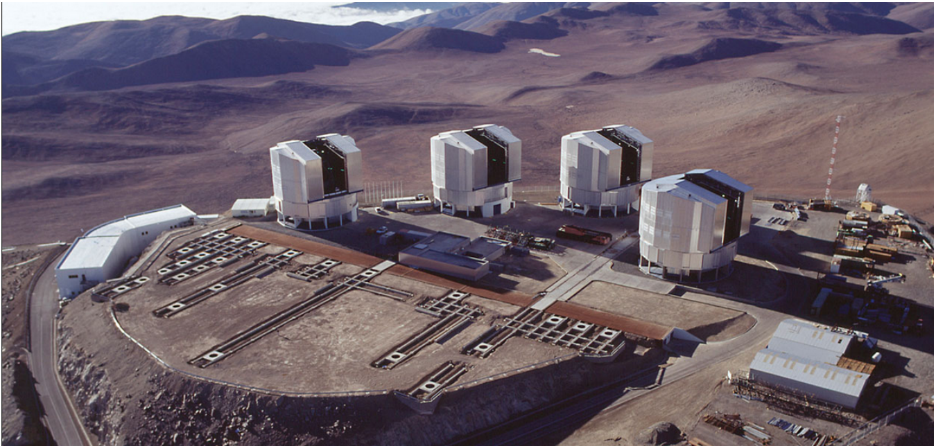
Abbildung 2: Das ESO-VLTI in der chilenischen Atacamawüste: die momentan wohl größte und bekannteste interferometrische Kopplung von Teleskopen. 3
